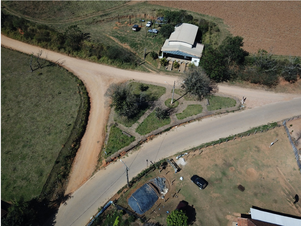
Figura 1 – Foto de drone atual do terreno. Fonte: Acervo do autor.
